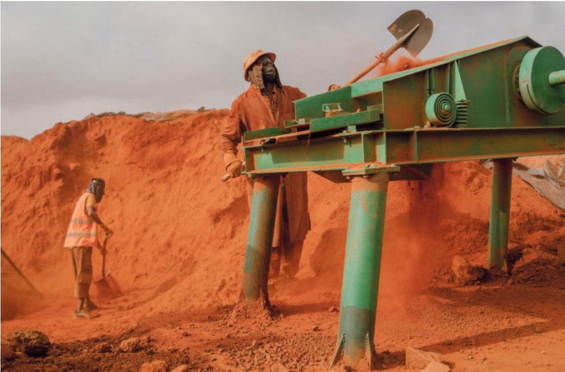
Arbeiders van Elementerre zeven rode aarde om die vervolgens samen te persen tot bouwstenen.
